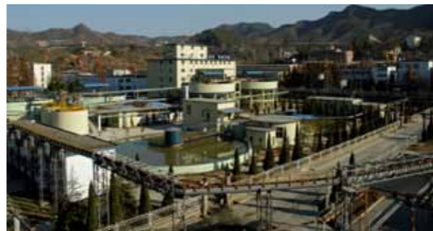
废水处理站全貌
